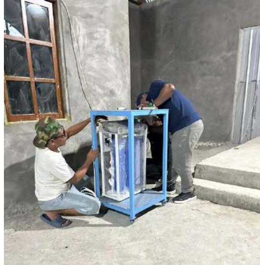
Gambar 8 Pemasangan alat reverse osmosis bersama dengan anggota gereja
