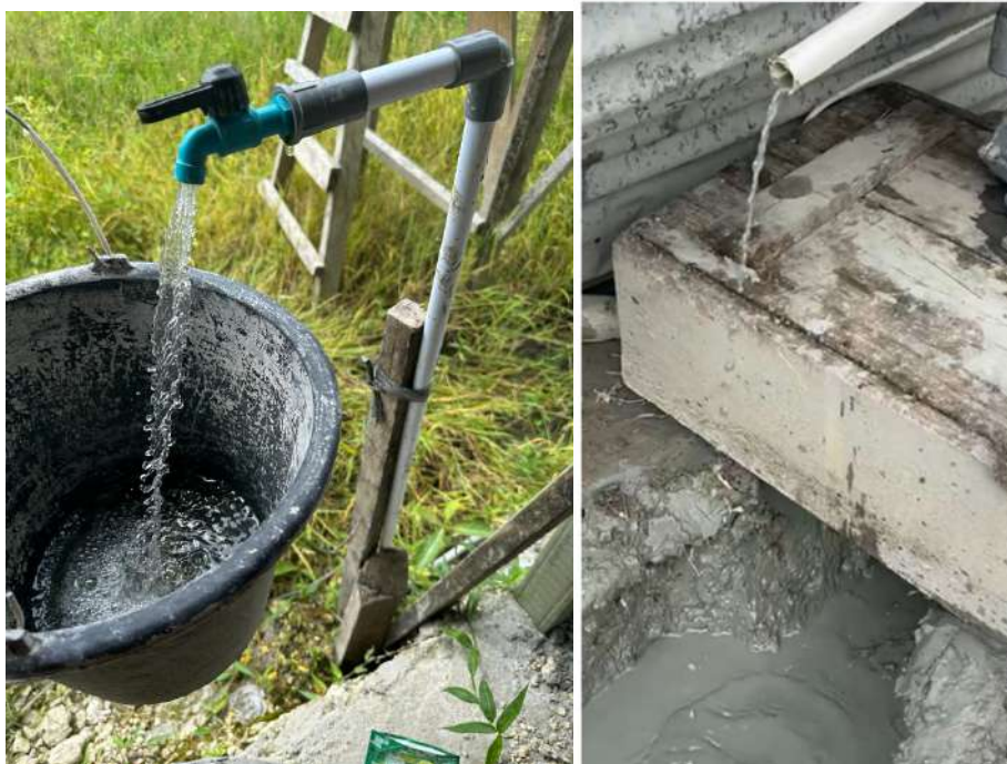
Gambar 7 Air yang keluar dari hasil sumur bor (kiri), air dari instalasi sumur (kanan)
