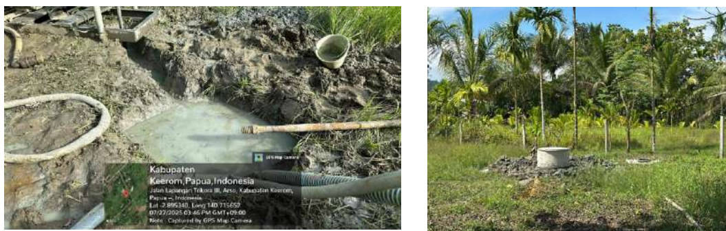
Gambar 5 Air yang keluar dari hasil pengoboran (kiri), Pembuatan sumur (kanan)
