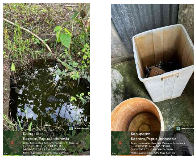
Gambar 1. Genangan air permukaan yang digunakan sebagai sumur dan kondisi kamar mandi
