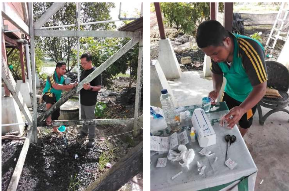
Gambar 2. Pemasangan Instalasi dan Pengujian Kualitas Air
