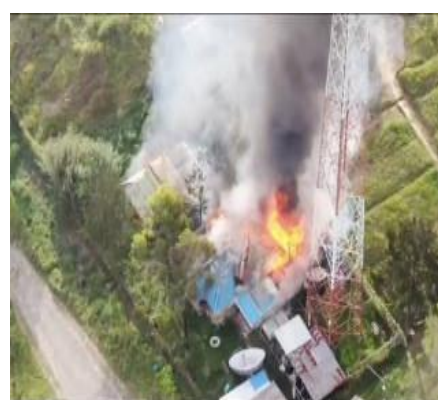
Gambar 3, Kondisi Jaringan Listrik Sumber : Penelitian Tahun 2023
