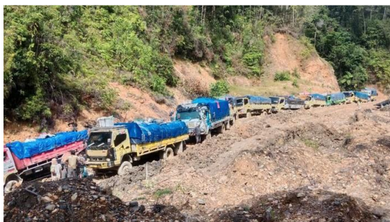
Gambar 1. Kendaraan macet akibat jalan yang rusak dan muatan yang berat
