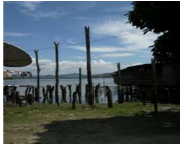
Gambar 9. Bekas Tiang Rumah dari kayu sowang yang masih bertahan hingga sekarang.
