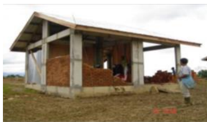
a. Komponen rangka beton
