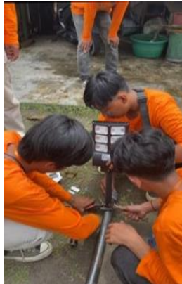
Gambar 1. Pemasanganudukan lampu panel surya pada tiang besi
