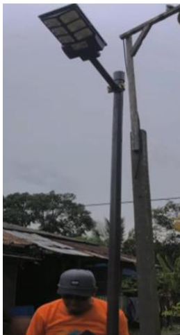
Gambar 2. Pemasangan lampu panel surya
